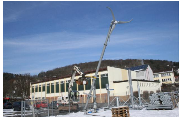
Abbildung 31: Aufstellung KWEA mit Steel-Root-Fundamentsystem von BFtec [35]
