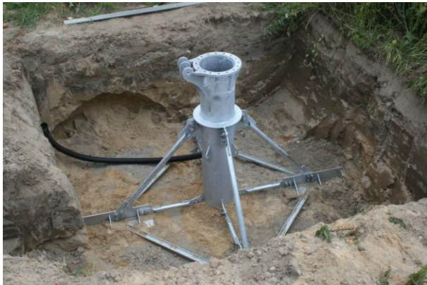
Abbildung 30: Steel-Root-Fundamentsystem von BFtec [35]
