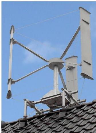
Abbildung 24: KWEA mit fester Dachanbindung [30]
