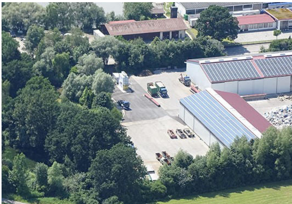
Abbildung 2.2.: Luftaufnahme des SmartPowerFlow-Speichers.
